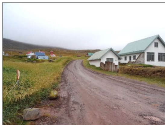
Mynd 12. Núverandi vegur liggur fast við húsvegg (SJ, 2019).
